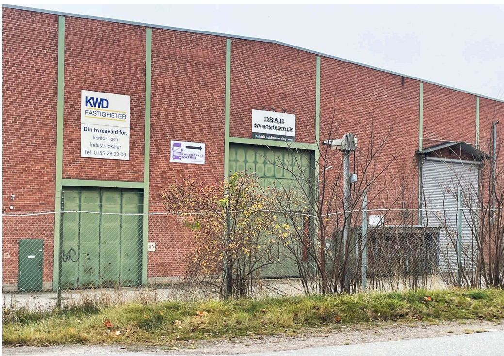
Figur 28. Foto som visar en av de röda tegelfasaderna i det befintliga industriområdet vid Nöthagen.
