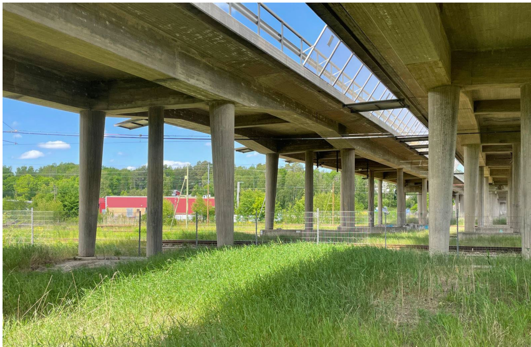
Figur 8. Foto mot nordväst, från Hemgårdsvägen i söder, som visar de befintliga motorvägsbroarna som korsar över järnvägen i nord-sydlig riktning. På andra sidan järnvägen syns befintliga industriverksamheter och skogshöjden i bakgrunden.
