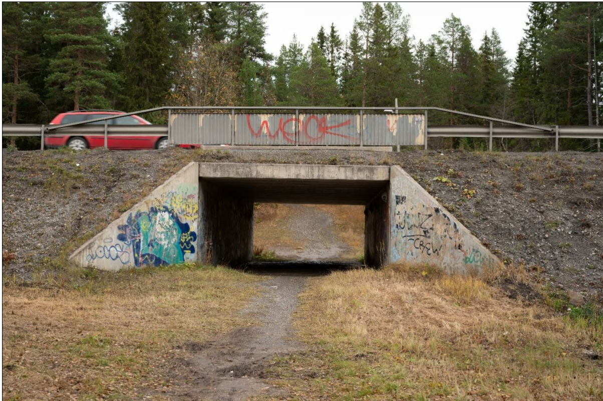
Figur 13 - En vanlig förekommande typ av bro över gångväg. Flertalet av broarna längs sträckan har likadana konstruktioner avseende bredd, höjd och längd. På bilden är bro nr 833.
