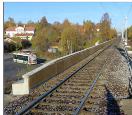
Figur. Exempel på låg, spårnära bullerskärm. Foto: Sound Block.
