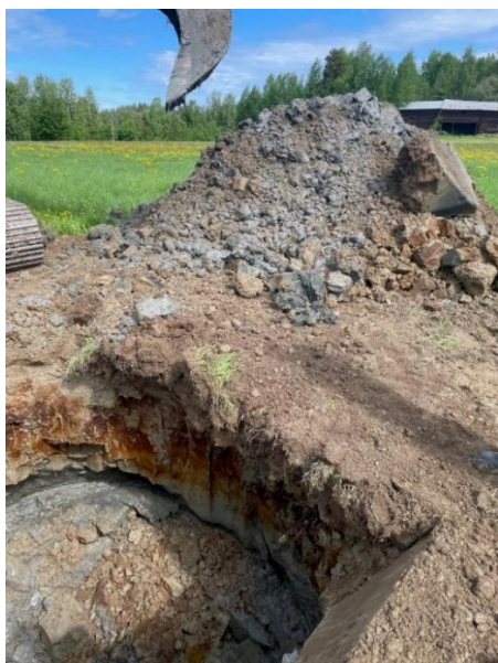
Figur 6.1 Det planerade och undersökta deponimaterialet (provgrop).
