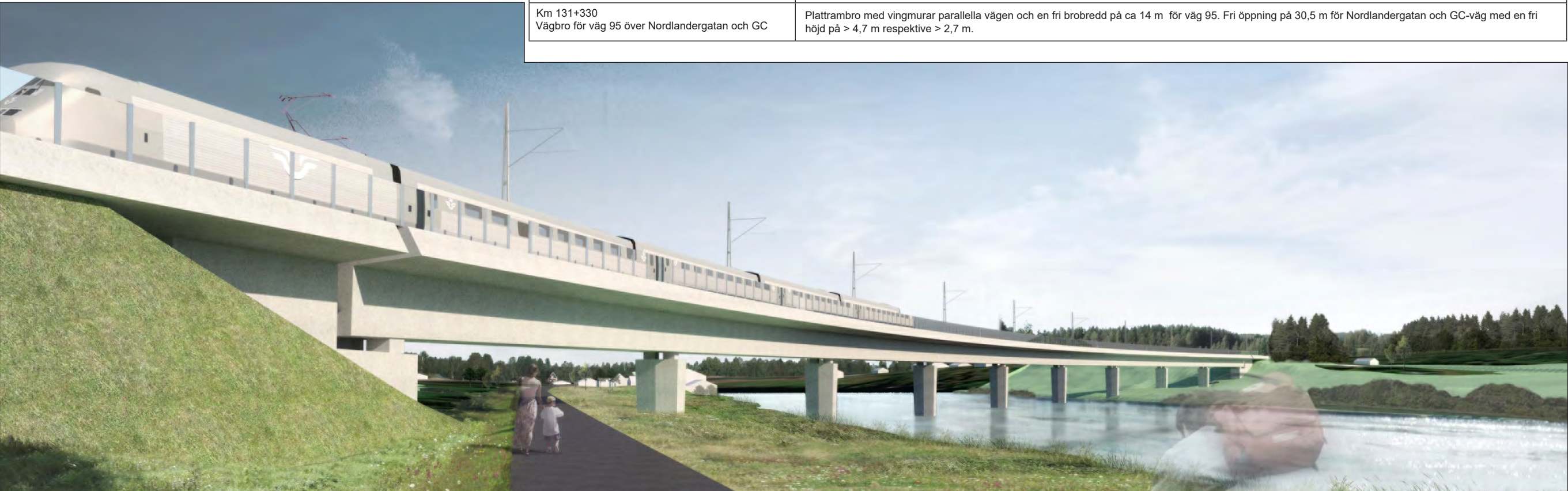
Figur 4.2:10 Broskiss, järnvägsbro över Skellefteälven, km 126+120. Vy från norra älvsstranden mot Södra Tuvan.
