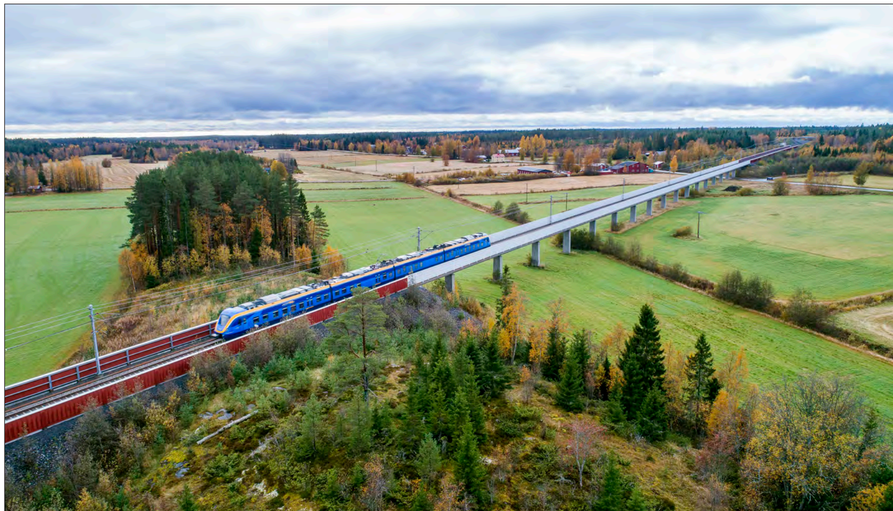
Figur 6.5:6 Spårnära bullerskärmar på Botniabanan, strax söder om Umeå. Foto: Norrtåg AB.
