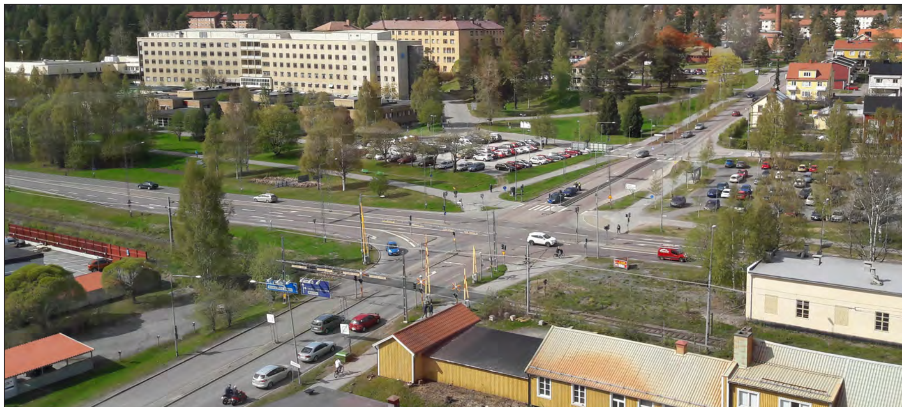
Figur 5.2.11 Lasarettsvägen korsning med väg 95. Foto: Skellefteå kommun.
