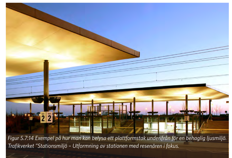
Figur 5.7:13 Väderskydd från Falkenbergs station som är både genomskinligt och väl ljussatt. Trafikverket "Stationsmiljö - Utformning av stationen med resenären i fokus.
