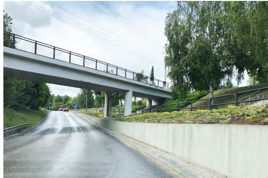
Figur 4.8:3 Exempel på genomsiktig bullerskyddsskärm på bro.
