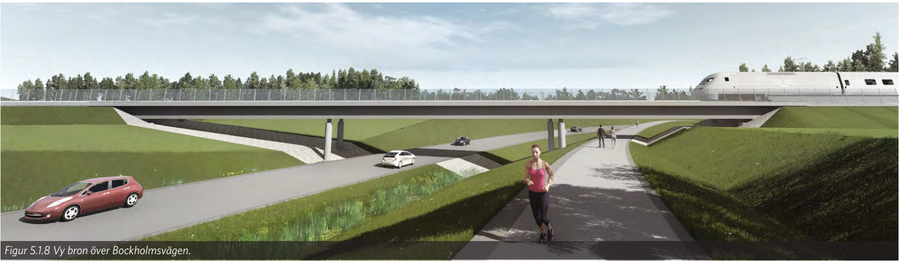
Figur 5.1:9 Exempel från Kiruna på hur utformningen av marken kring brostöden kan utföras under Bockholmsbron.
