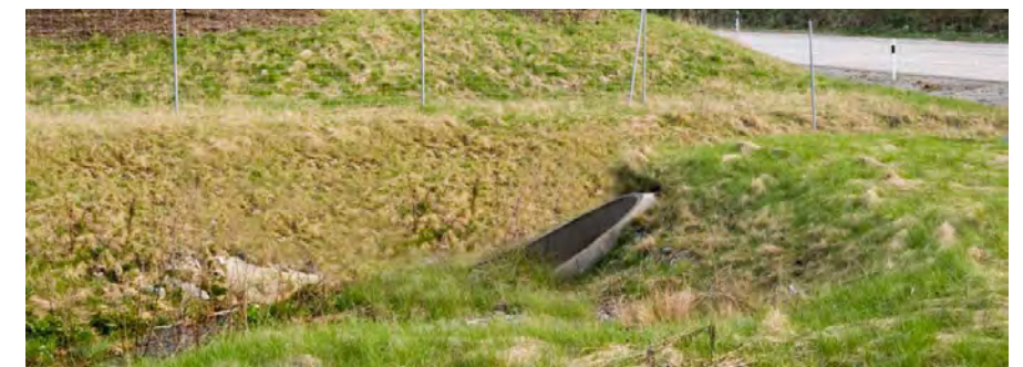
Figur 4.5:1 Omsorgsfullt utformad trumöppning bidrar till en god finish. Vägbilder, Trafikverket
