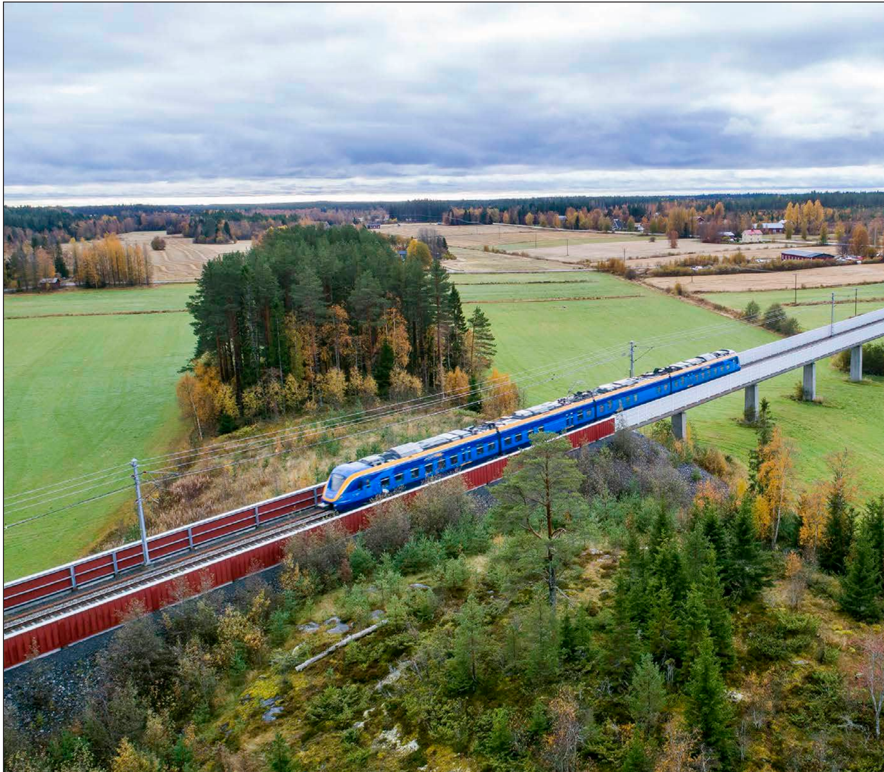
Figur 4.3:2 Exempel på spårnära bullerskyddsskärmar från Botniabanan. Foto: Norrtåg.
