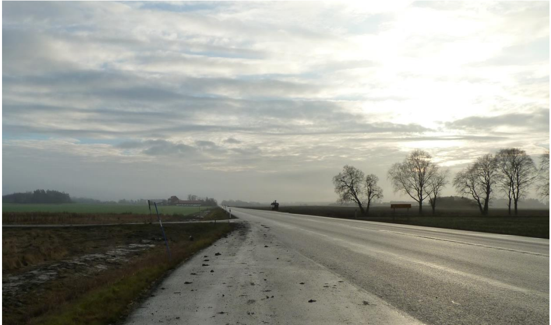
Figur 4.2.1.1, Bild tagen i riktning söderut längs väg 600 på avsnittet mellan Lövstalöt och Uppsala.
