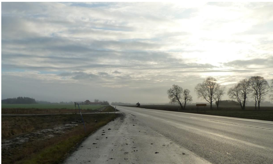
Figur 4.4.1. Bild tagen i riktning söderut längs väg 600 på avsnittet mellan Lövstalöt och Uppsala.
