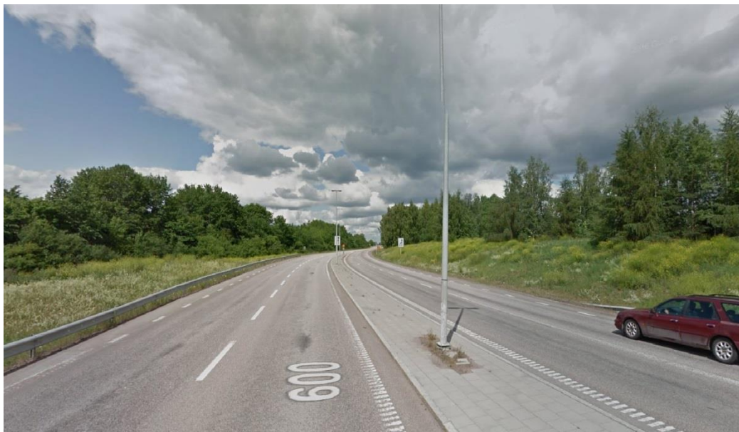
Figur 4.4.1. Bild tagen i riktning norrut längs väg 600, ståendes där befintlig cykelbana passerar under väg 600.
