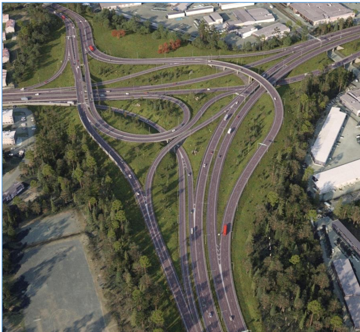
Figur 33. 3D-bild som visar bankslänter för avfartsramp/ bro mot norr med befintlig tallskogsridå mot industrimark. Ny vegetation har illustrerats i sidoområdena. Med tiden kommer den nya vegetationen medföra att bankslänterna tonas ned i landskapsbilden.
