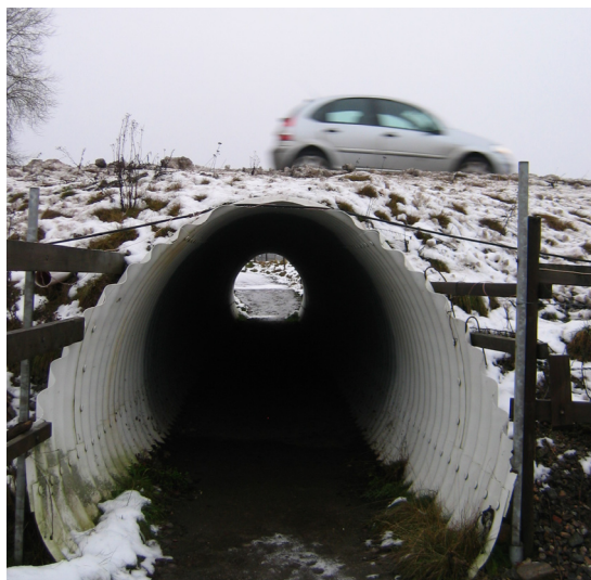
Koport under väg 56 i öppet landskapsrum vid Sund.
