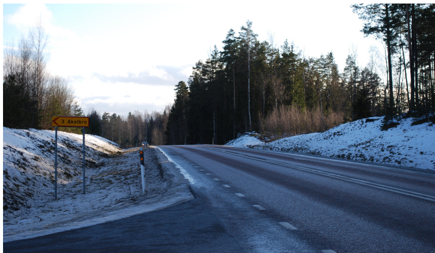
Vy från norra infarten mot Strängstorp har skymd sikt mot söder på väg 56 över krönet. Infarten leder vidare mot badplats vid sjön Mellanmalmen,
