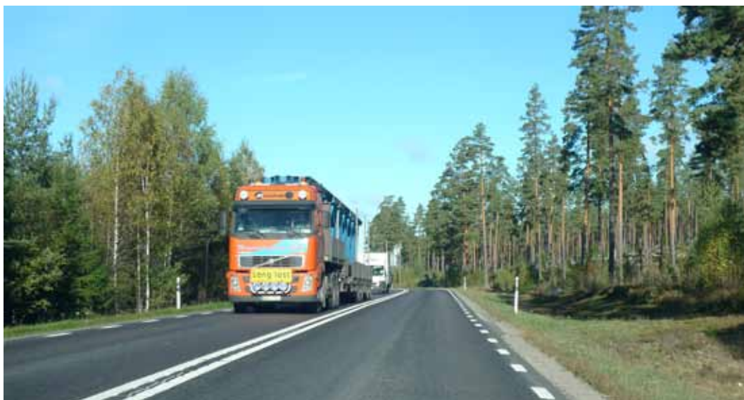
Figur 2. Dagens väg är en vanlig landsväg med hög andel tung trafik.
