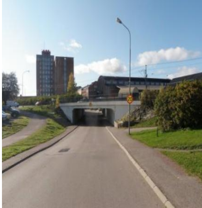
Figur 5 Bro 20-754-1 över Tunnelgatan, vid huvudentré till ABB Ludvika, km 4/330.
