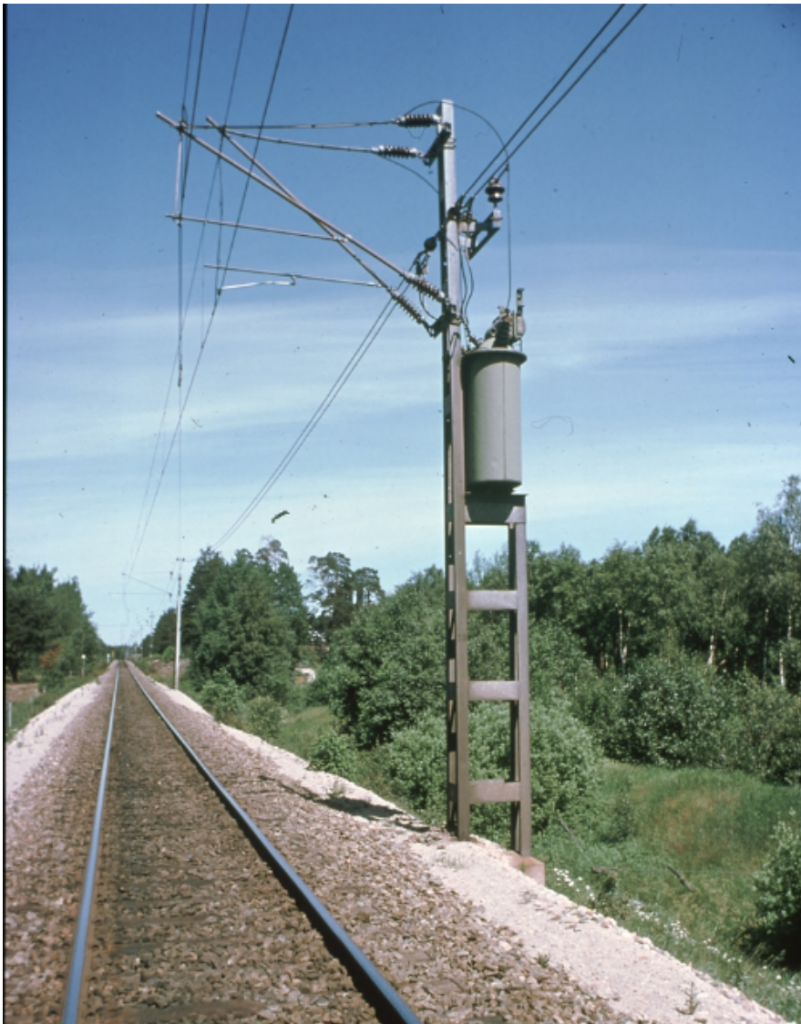
Figur 10. Exempel på hur en kontaktledningsstolpe kan se ut. Källa: digitalmuseum.org.
