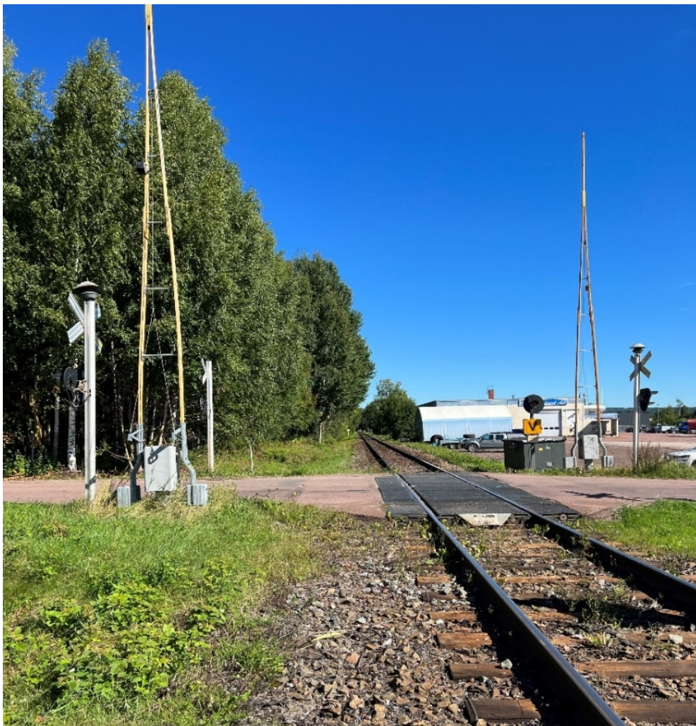
Figur 5. Vägskyddsanläggning med bommar och kur.
