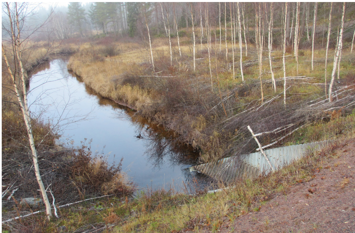
Figur 4.9 Vanån, vägens norra sida.
