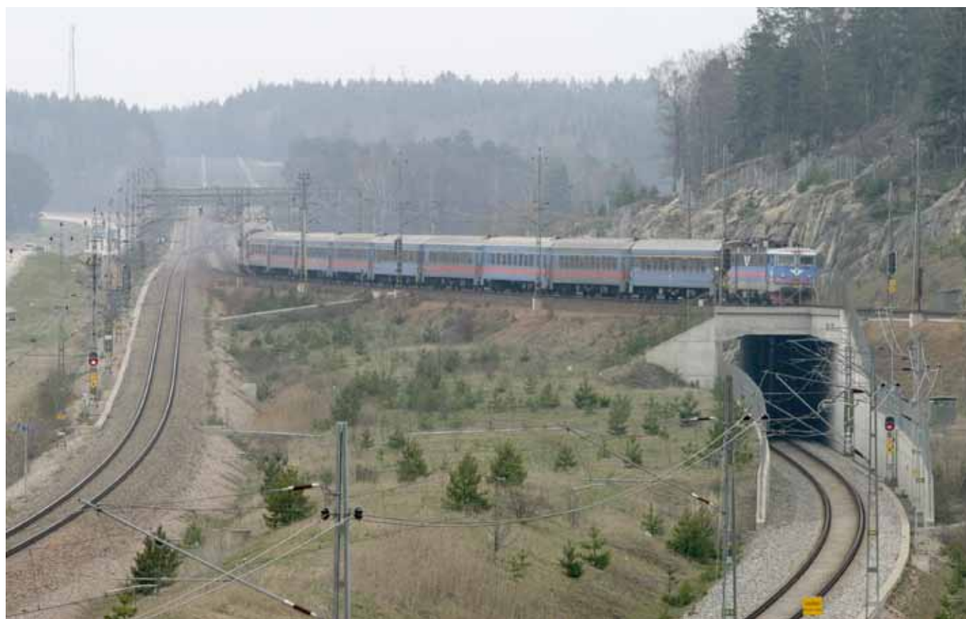
Exempel på en kopplingspunkt mellan banor där spåren korsar planskilt.
