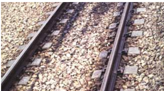
Figur 4.7.1 Traditionell banuppgbyggnad med räler, sliprar och makadam.
