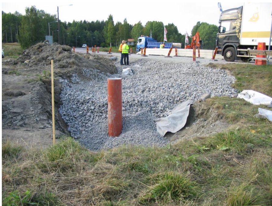
Bild 5 - Geoteknisk åtgärd Fiskja
