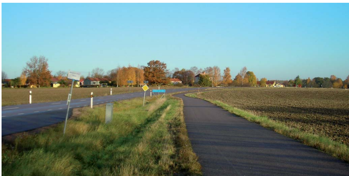
CG-väg parallell med väg 252 norr om Kolbäck mot Sörstafors
