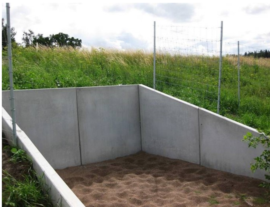
Figur 5.2.9. Exempel på utformning av viltuthopp
