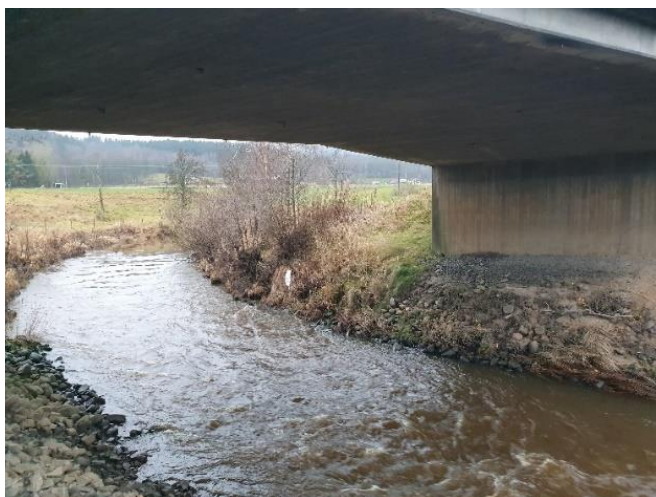
Figur 34. Faunapassage under bro över Surtan.
