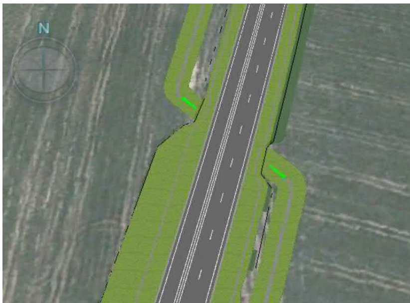
Figur 32 Krondiket leds i trumma under vägen.
