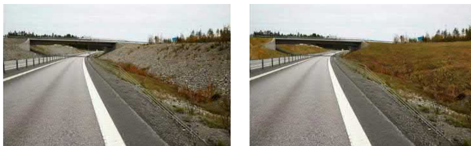
Figur 40 Exempel på slänt med grovt kross och exempel på vägkant som ger ett grönt och vårdat intryck. Bild: Vägbilder, Trafikverket, 2015-10-19.
