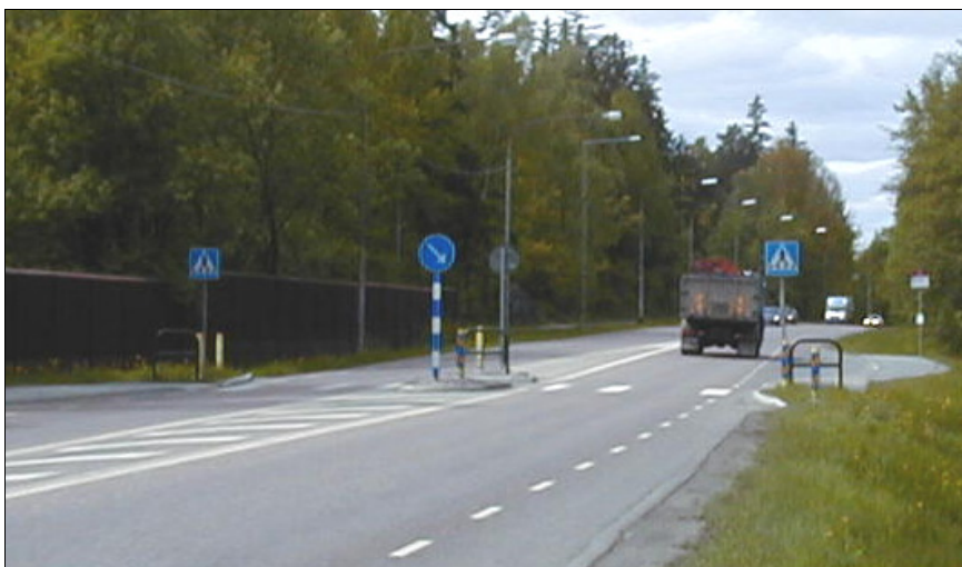
Bild 5 Gångpassage vid Jakttskyttebanan
