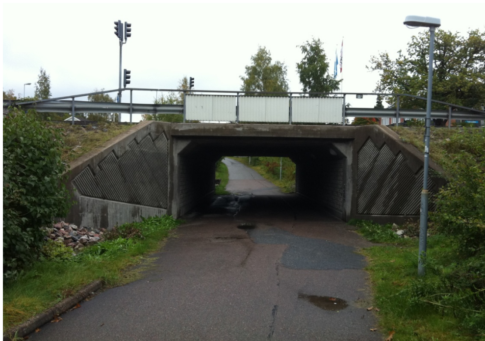
Bild 6: Befintlig GC-tunnel under väg 262 vid Lomvägen/Fasanvägen
