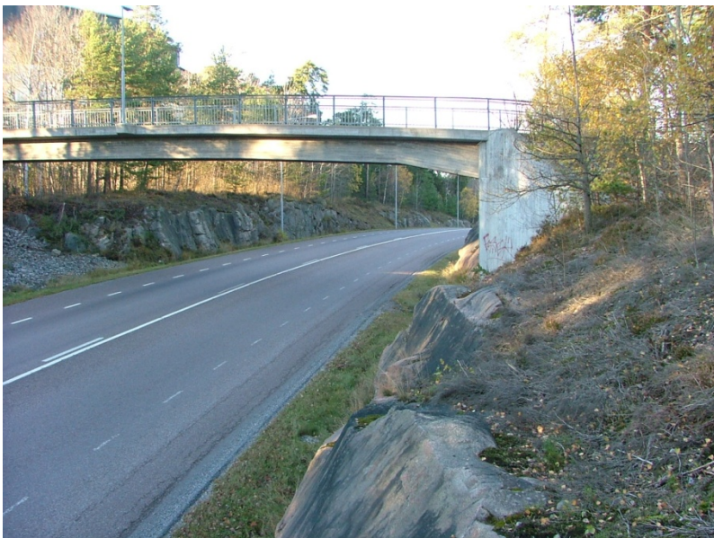
Bild 2: Väg 262 vid befintlig GC-tunnel på Sollentunasidan
