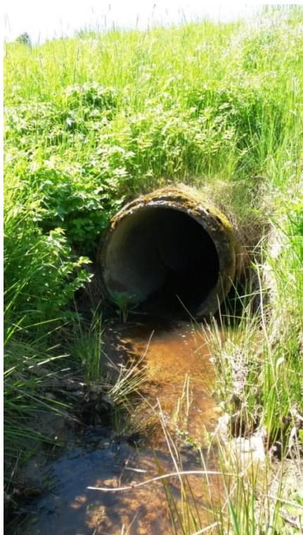
Figur 40. Trumma som leder Sätrabäcken under väg 262 (nordvästra sidan av vägen).
