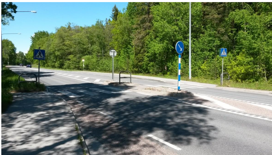
Figur 9. Övergångsställe/passage i plan vid busshållplatsen Jaktsskyttebanan.
