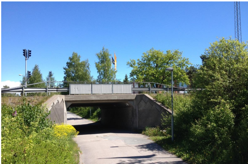
Figur 8. Gång- och cykelport under väg 262 i korsningen med Lomvägen och Fasanvägen.
