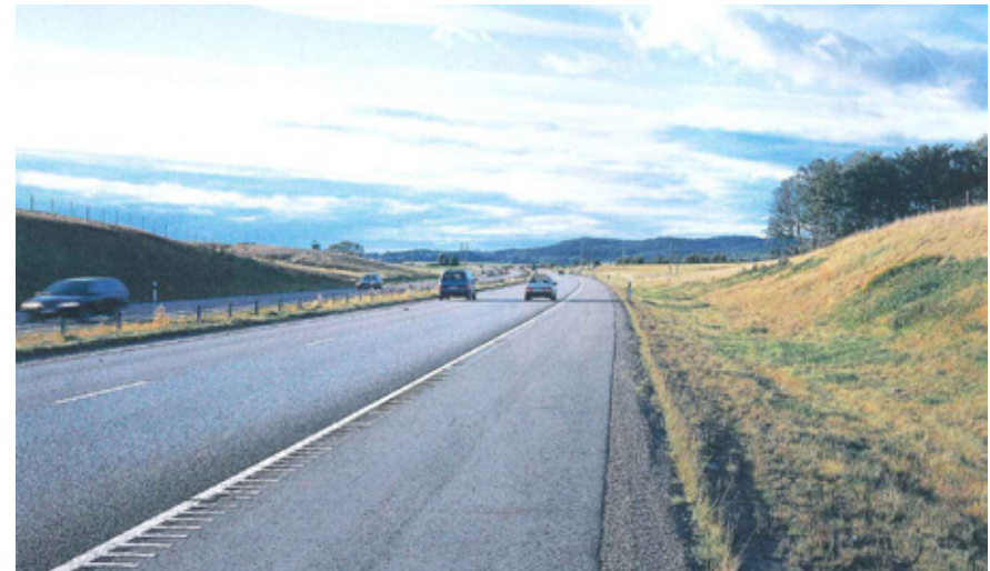
Bilden visar ett exempel på en propellerslänt. Övergången blir mjuk och vägen upplevs integrerad i landskapet (Hermansson 1999).
