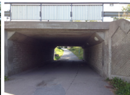
Befintlig gång- och cykelpassage under väg 262 förlängs, väggarna gjuts mot liknande matriser.
