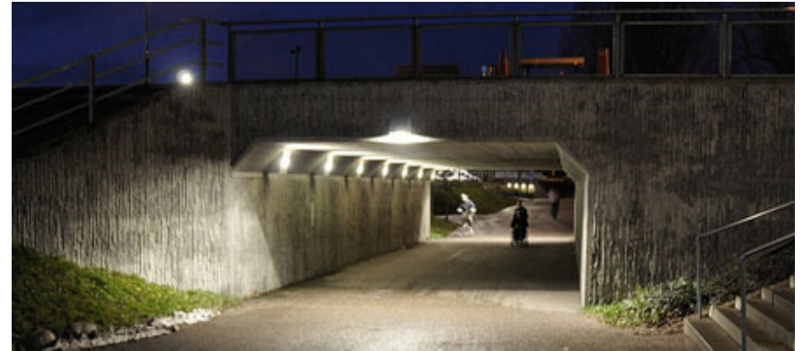
Exempel på väl belyst passage där kontrasten mellan port och omgivning inte är för stor och där även vingarna är belysta (arboga.se, tekniska förvaltningen)
