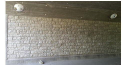
Väggarna i den befintliga GC-porten vid Lomvägen-Fasanvägen har gjutits mot en matris som efterliknar naturstensbeklädnad.
