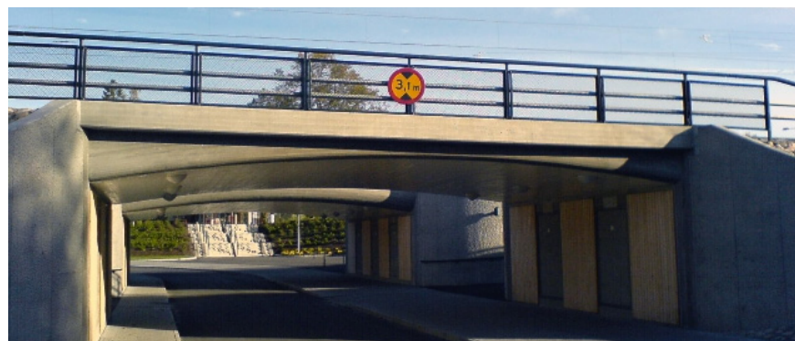
Exempel på broräcke med nätgrind (fmk.se).
