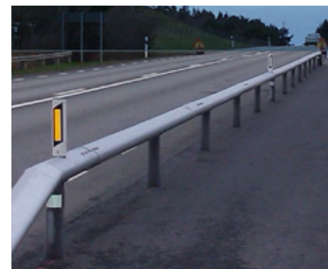
Exempel på dubbelsidigt skyddsräcke (varmforzinkning.se).
