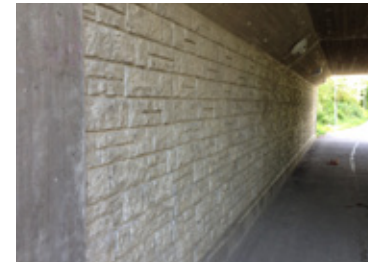
Väggarna i den befintliga GC-porten vid Lomvägen-Fasanvägen har gjutits mot en matris som efterliknar naturstensbeklädnad.
