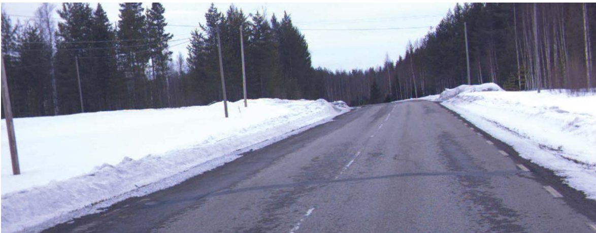
Figur 2.5.2. Korsande ledningar och belysningsstolpe vid Nedre Flåsjön.
