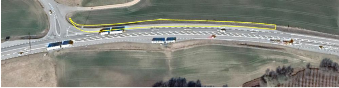
Vy över korsningen väg 1900/väg 1898
