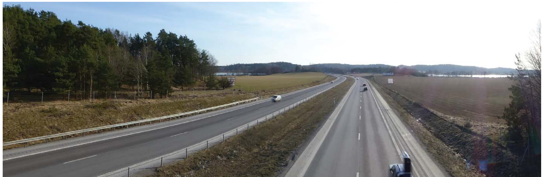
Figur 10.3 E4 passerar mellan sjöarna vid Hölö, vy mot söder.
