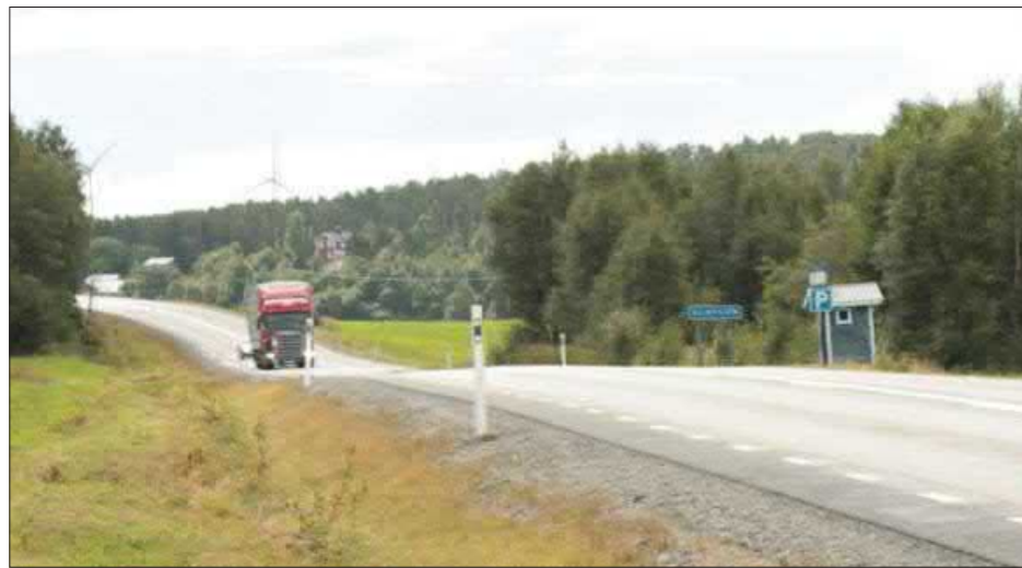
Figur 38. Busshållplats Vallen - södergående. Hållplats på parkeringsficka.
