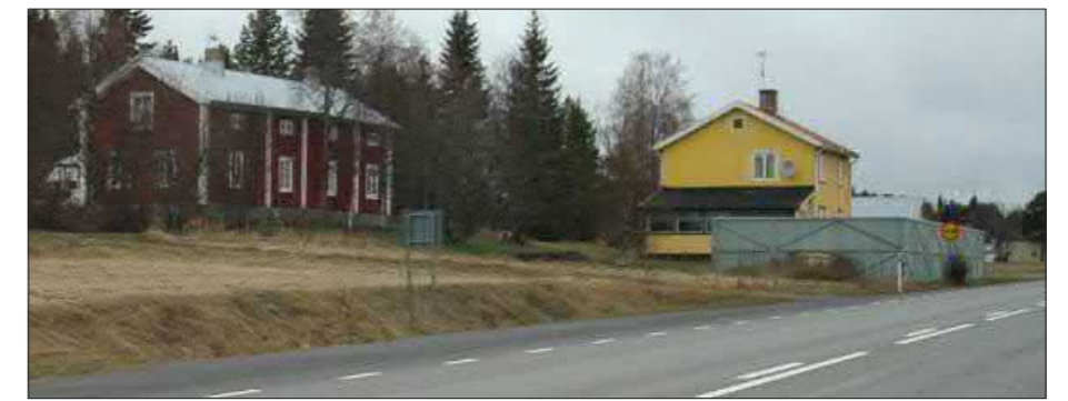
Figur 15. Enda bullerskärmen längs sträckan står vid ett hus strax söder om korsningen i Gumboda.
