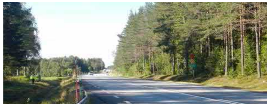
E4 är idag väl anpassad till landskapet både sett från vägen och sett från sidan. Det är viktigt att sträva efter att den karaktären behålls så långt som möjligt vid ombyggnaden trots att kraven på nya räcken, stängsel, nya slänter mm gör det till en svår utmaning.
