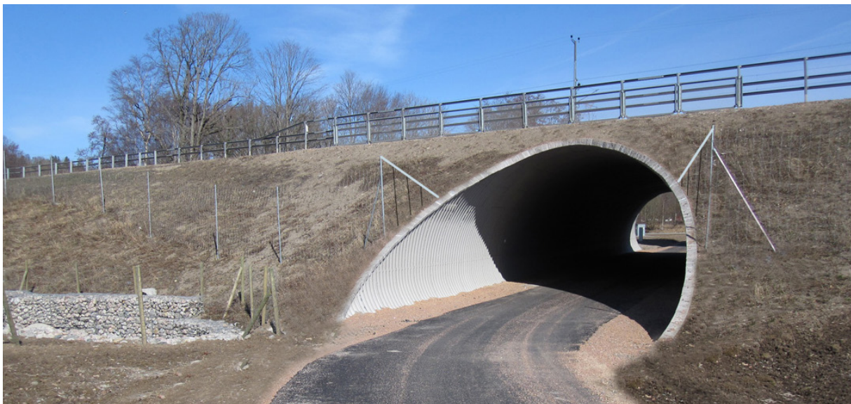
Bild 10. Princip för viltstängslets möte med rörbron vid Strängstorp (källa originalbild ViaCon 2009, bilden har redigerats).
