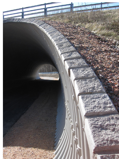
Bild 7. Till vänster. Exempel där rörets avslutning har dolts med betongsten och synlig del av röret nollas ner till marknivå. Observera att slänten ska vara vegetationstäckt ända fram till betongstenen. Exempel från väg E6 vid Saltkällan (källa originalbild ViaCon 2009, bilden har redigerats).
