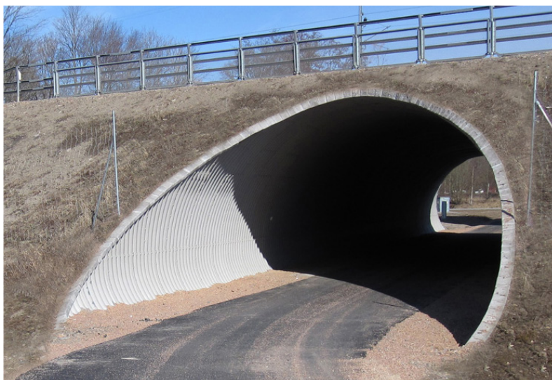
Bild 7. Till vänster. Exempel där rörets avslutning har dolts med betongsten och synlig del av röret nollas ner till marknivå. Observera att slänten ska vara vegetationstäckt ända fram till betongstenen. Exempel från väg E6 vid Saltkällan (källa originalbild ViaCon 2009, bilden har redigerats).
