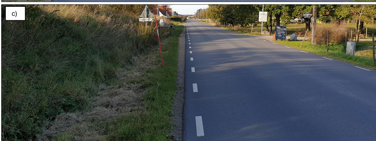
Figur 5. Fotografier är tagna av Sweco i samband med platsbesök 2019-10-08. a) Befintligt läge B (en stolpe) framför Magnarps skola. b) Jordbruksmark med grövre träd (åt höger). c) Vägdike där gång- och cykelbana ska anläggas.
