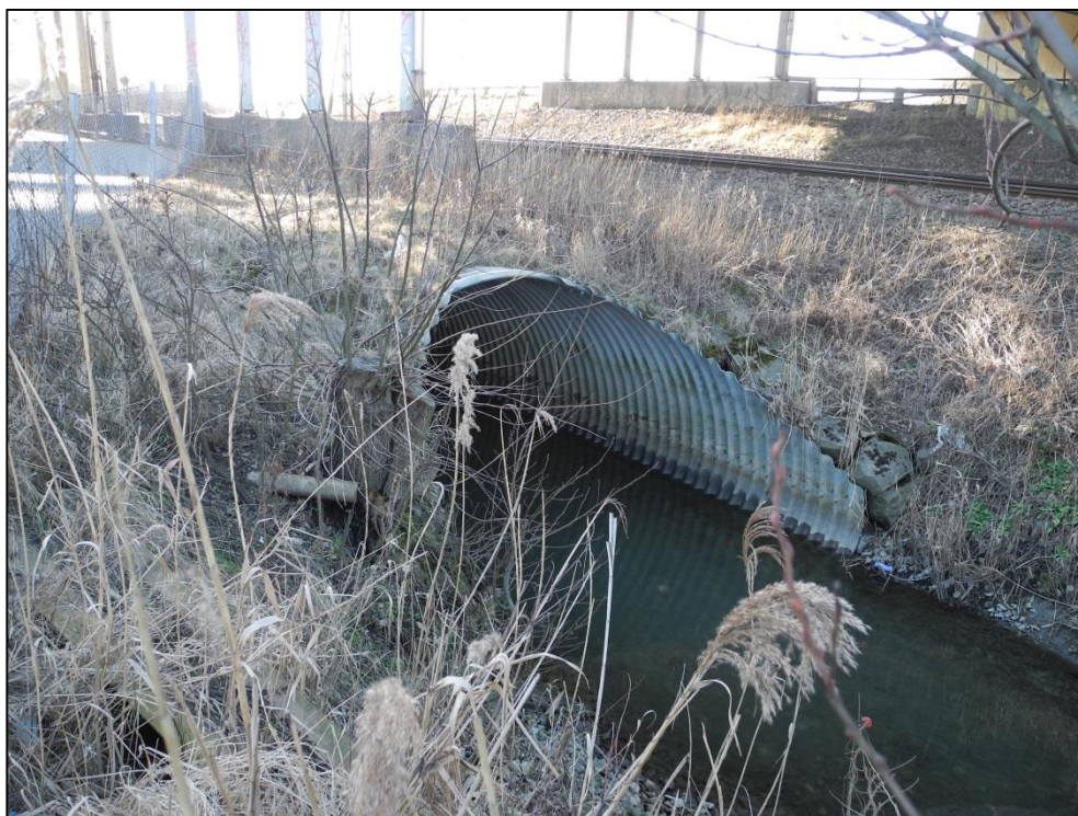
Figur 9.12 Elipsformad trumma av korrugerad plåt vid E6/E20, bredd cirka 3,5 m, mellan Åkarp och Arlöv. Kommer att ersättas av två betongledningar med innerdiameter minst 2200 mm.
