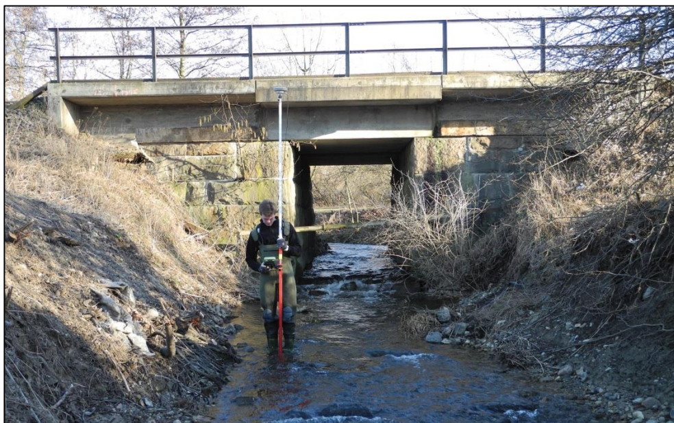
Figur 9.13 Bro vid stambanan i Arlöv. Bredd cirka 2,45 m, höjd cirka 2,7 m. Kommer att ersättas av bro med bredd cirka 4,5 m.
