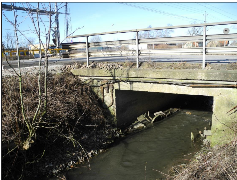
Figur 9.11 Bro vid Alnarspvägen i Åkarp. Bredd varierar mellan 1,7–2,8 m, höjd cirka 1,7 m. Kommer att ersättas av kulvert under Sockervägen med bredd minst 3 m, höjd minst 2 m.
