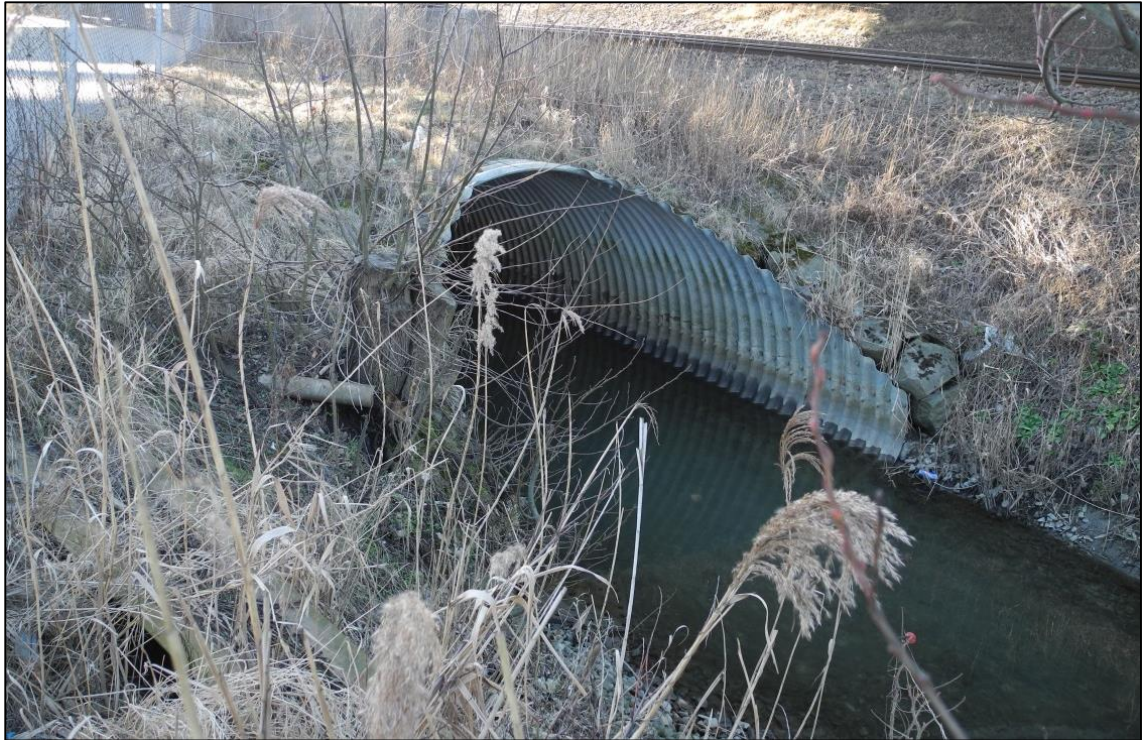
Figur 3.6 Elipsformad trumma av korrugerad plåt vid E6/E20, bredd cirka 3,5 m, mellan Åkarp och Arlöv. Kommer att ersättas av två betongledningar med innerdiameter 2200 mm.
