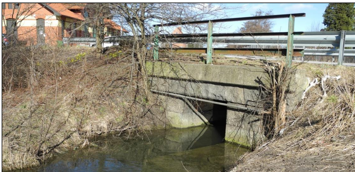
Figur 3.4 Bro vid Stationsvägen i Åkarp. Bredd 1,65 m, höjd 1,5 m. Kommer att rivas i byggskedet och breddas i driftskedet. Ersätts med en rörbro med fri bredd 3,70 m.
