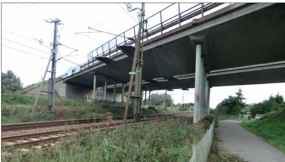
Bild 2.6. Vägbroar för väg E6/E20 vid Trafikplats Alnarp. Påfartsrampen till väg E6/E20 syns i det nordvästra brofacket till vänster i bild.
