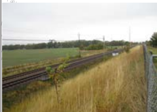
Bild: Grässlänt (slänt 1:2) mot järnväg.
