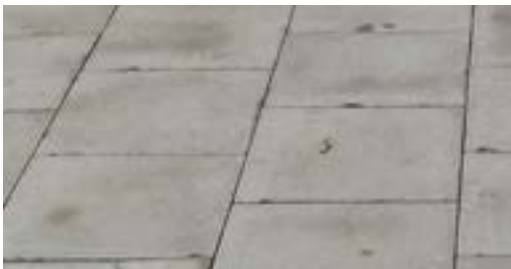
Betongplattor i halvförband
