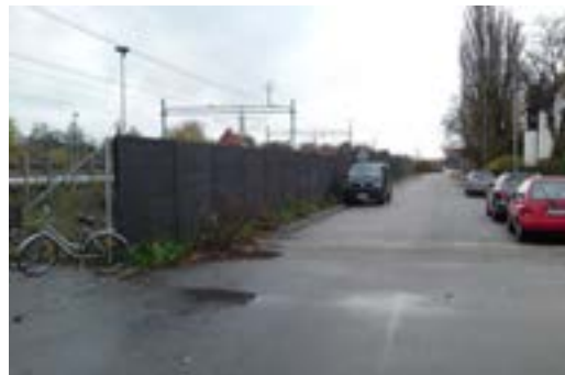
Bullerskyddsplank på den västra sidan om spåren
