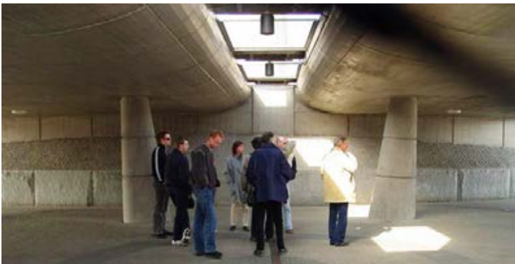
Ljusedsläpp i tak inne i tunnel. Hjalmar Brantings plats, Göteborg.
