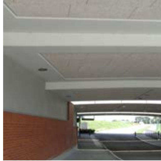
Ovan. Ljudabsorbenter i tunneltak. Falkenberg station.
