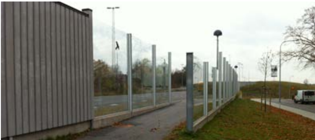
Ovan. Bilden visar hur skärmarna måste gå omlott vid öppningar för att ljudet inte ska läcka ut emellan.
