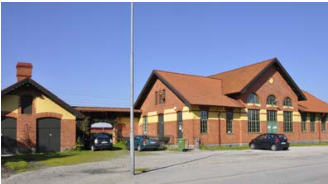
Den tegelklädda stationsbyggnaden. Här har använts rött tegel med gula detaljer som kontrast.
