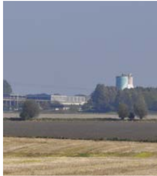
Skanskas silobyggnader vid den nedlagda betongfabriken i Hjärup syns vida omkring.
