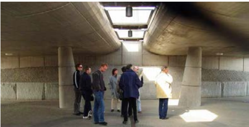
Ljusnedsläpp i tak inne i tunnel. Hjalmar Brantings plats, Göteborg.
