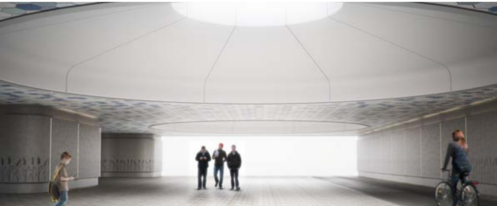
Gång- och cykeltunnel under järnvägen med takkupoler i glas som släpper ner dagsljus.
