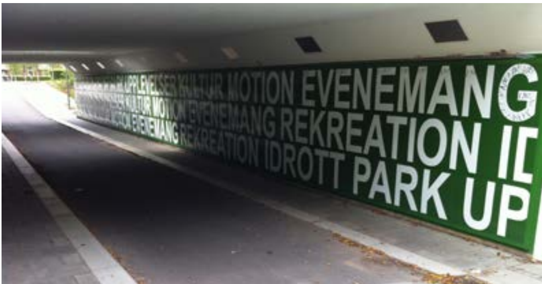
Fredriksdalstunneln, en gång- och cykeltunnel med ljusinsläpp från taköppning. Väggarna är klädda med kassetter i glasemalj.
