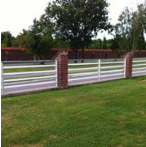
Ovan. Bullerdämpande genomsiktliga skärmar längs Kullavägen i Helsingborg. Element från kyrkogårdsmuren tas upp i den nya skärmen.
