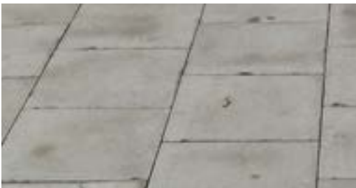
Betongplattor i halvförband
