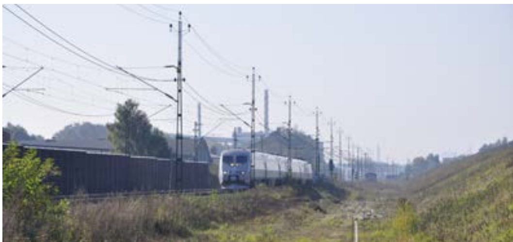
Söder om stationsläget har anlagts höga bullerdämpande skydd i form av rödmålade plank respektive vall.
