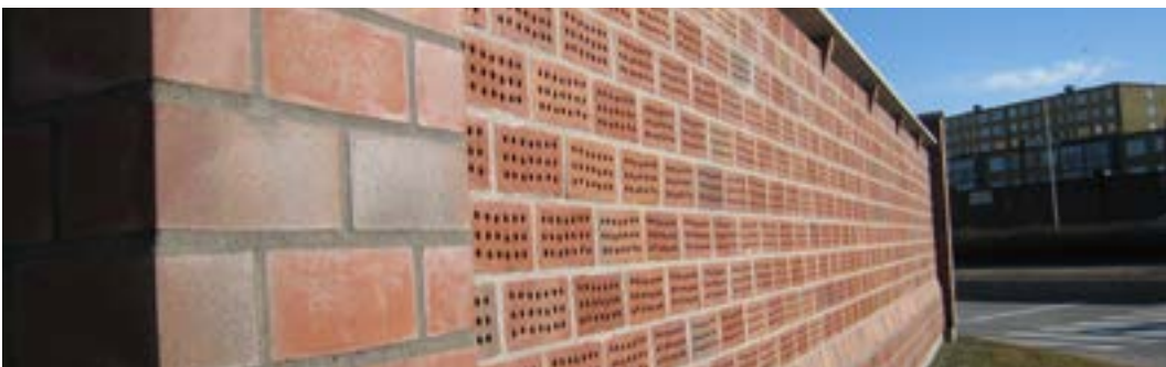
Bullerdämpande mur mot Lorensborgsvägen i Malmö, byggd med håltegel.
