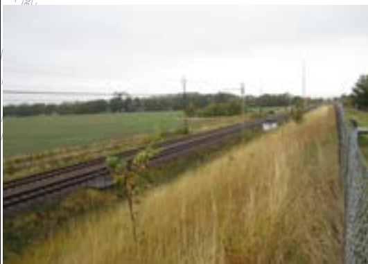
Bild: Grässlänt (slänt 1:2) mot järnväg.
