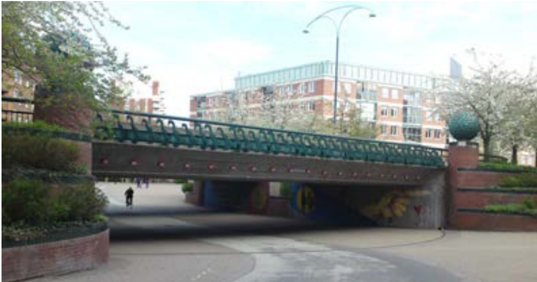
Gång- och cykeltunnel vid stadshuset i Malmö. Anslutande omgivning har en flack lutning för god överblick.
