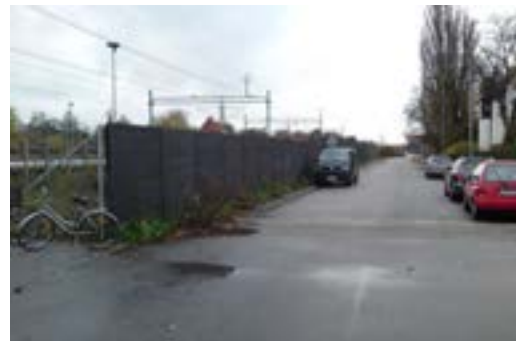
Bullerskyddsplank på den västra sidan om spåren
