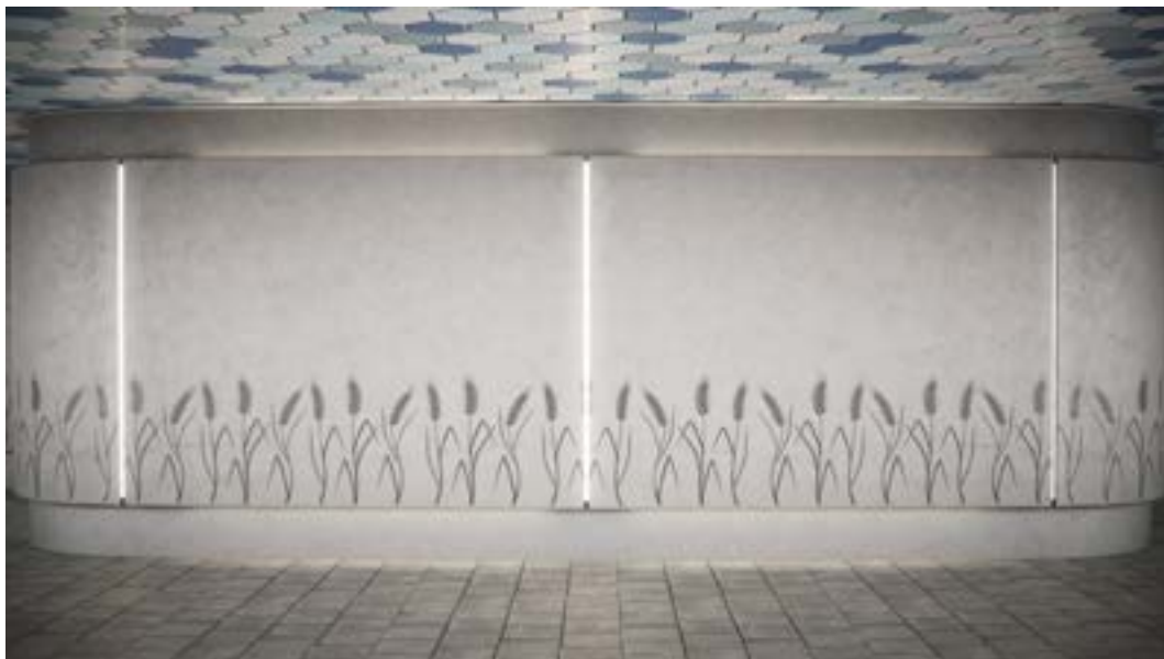
Betongväggarna kan exempelvis förseas med infälld belysning. Väggarna kan ges ett konstnärligt innehåll med grafisk betong.
