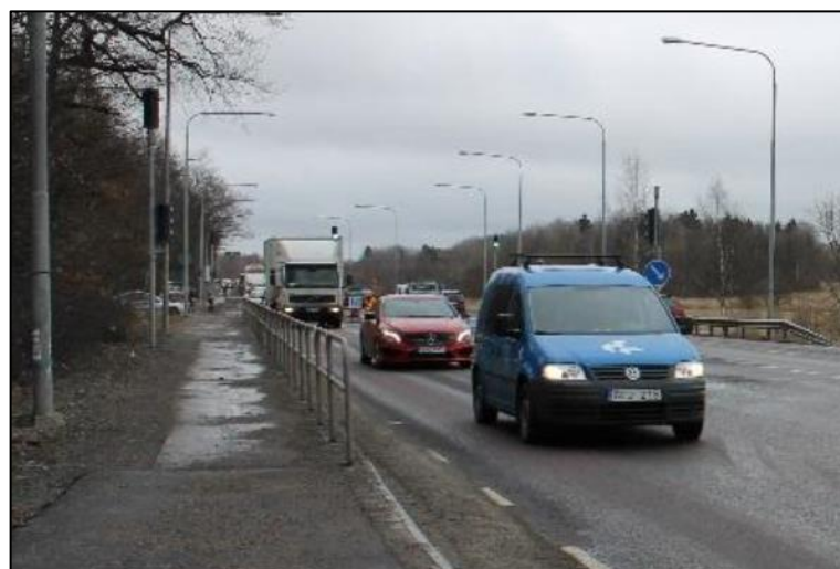
Figur 9. Befintlig GC-väg mellan Bergavägen och Katrinebergsvägen, på norra sidan om Glömstavägen, är smal och separerad med kantsten och räcke.
