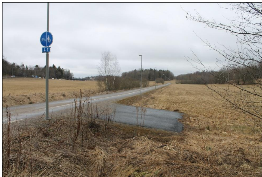
Figur 8. Befintligt gång-och cykelstråk söder om Glömstavägen, som skymtar i bakgrunden.
