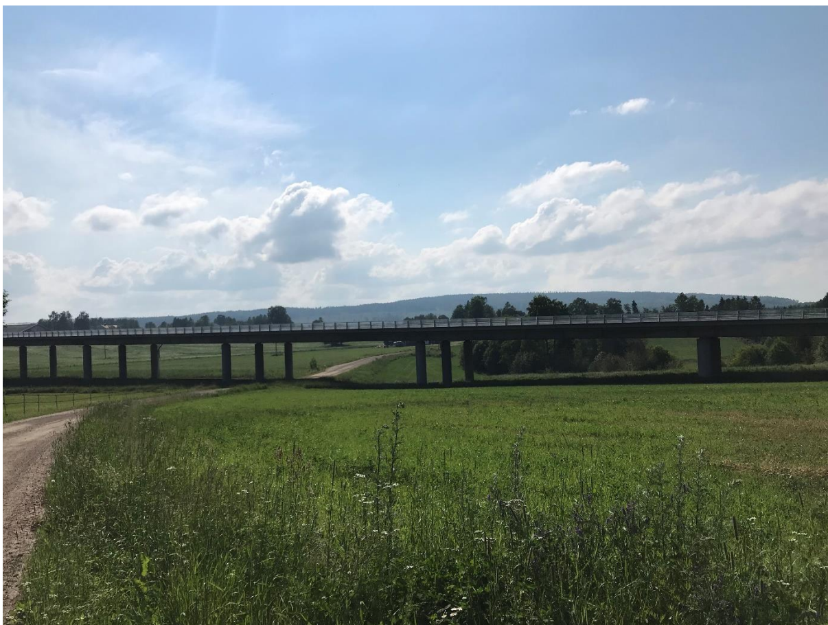
Figur 10. Landbron i Nolby. Vyn är tagen åt väster mot Ljungan. På bilden syns även Västbovägen under bron samt bakom bron den skogsdunge som omger Bytjärnen.
