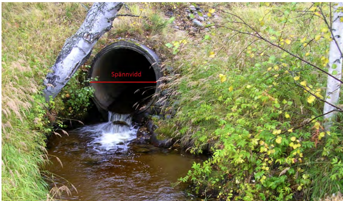
Spännvidd för trumma. Foto: Trafikverket.
