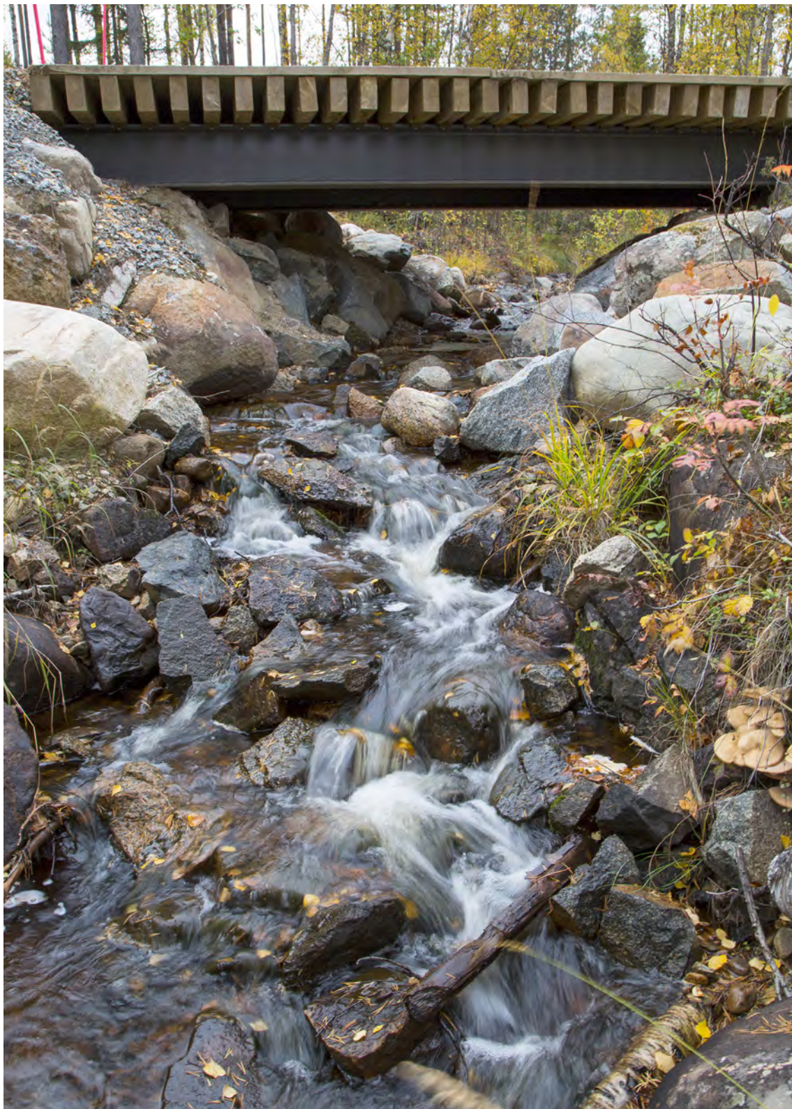
Enkel balkbro med naturlig strand och återskapad botten i bäcken. Foto: Fredrik Broman, www.humanspectra.com .
