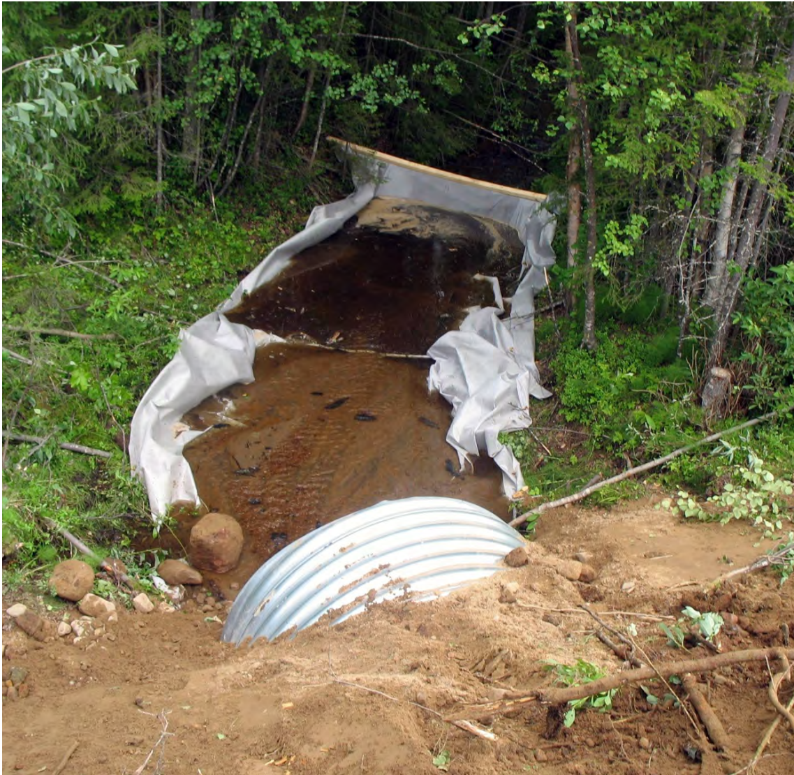
Sedimentfällor kan anläggas för att minimera grumling under anläggningstiden. Foto: SCA.
