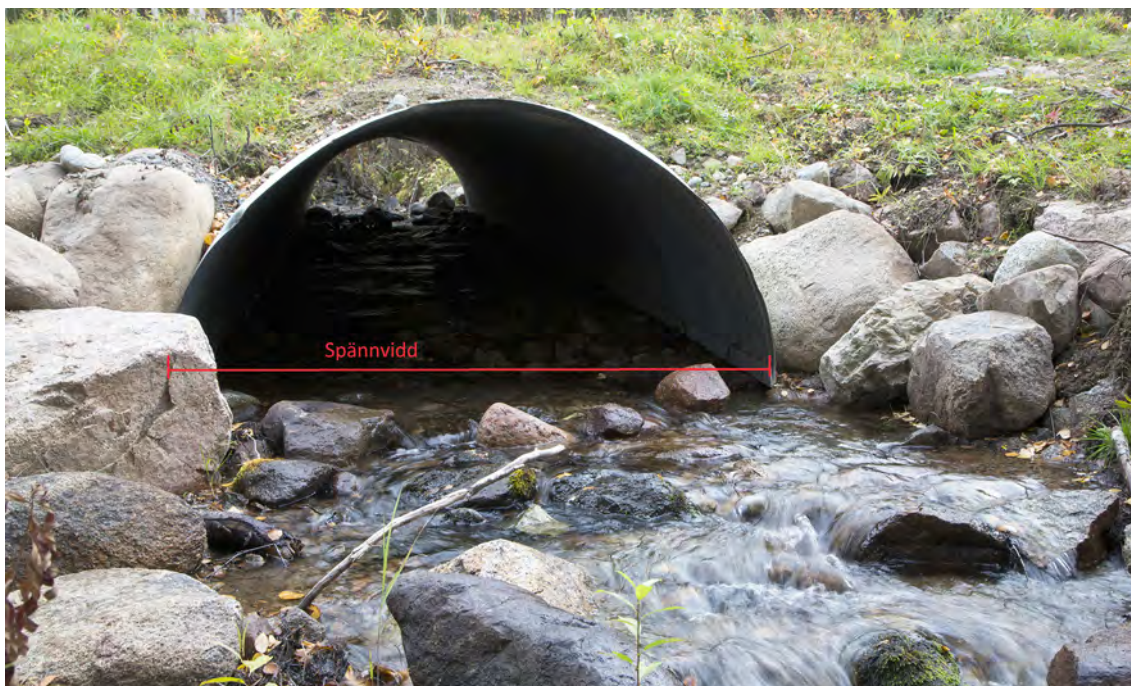
Spännvidd för valvbåge. Foto: Fredrik Broman, www.humanspectra.com .
