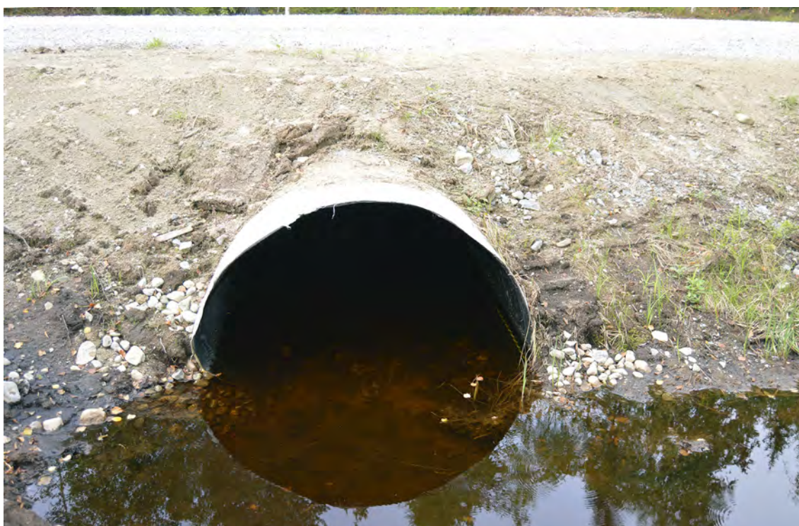
Lågbyggd trumma kan t ex användas om vägbanken är låg. Foto: Trafikverket.
