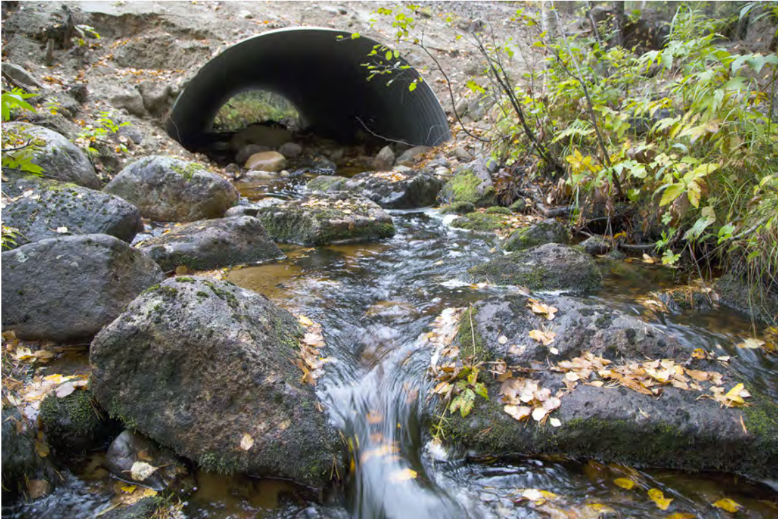
Valvbåge med plåtfötter gör det möjligt att återskapa en naturlig botten. Foto: Fredrik Broman, www.humanspectra.com .
