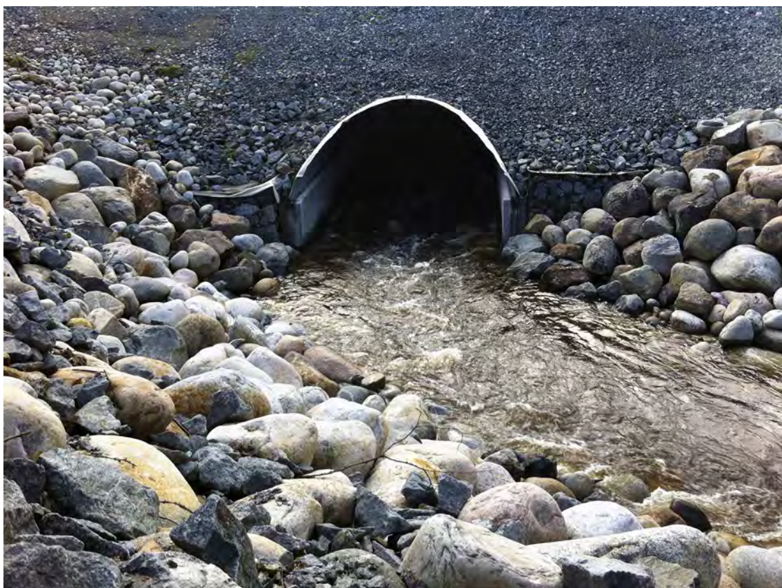
Erosionsskydd av natursten i slänterna vid en anlagd bro. Foto: Trafikverket.
