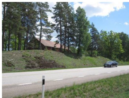
Bild 2. E22 passerar Misterhultsåsen vid Målbäcken strax söder om etapp 2. Vy mot sydost.
