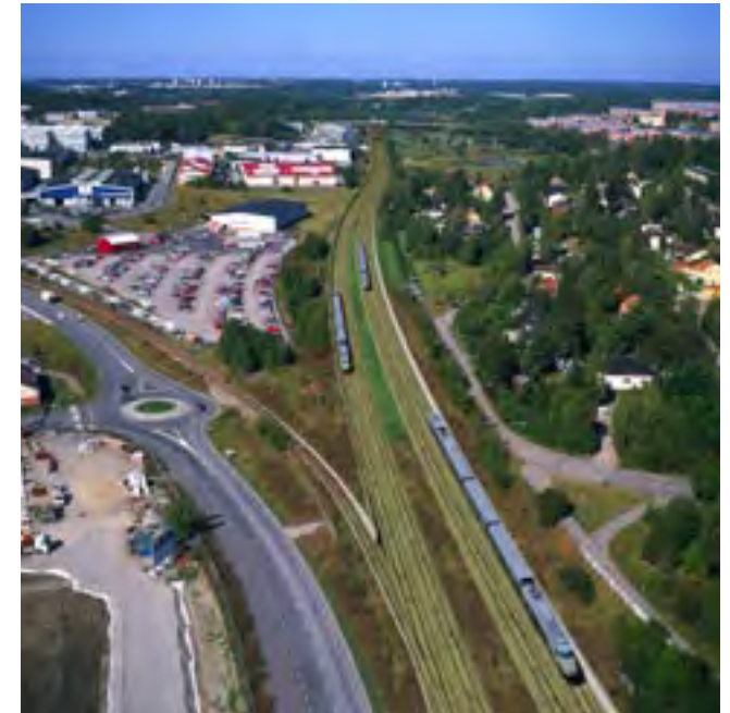
Möjlig kurvrätning norr om Spånga station. En breddning gör att järnvägens barriärverkan stärks i detta bostads- och verksamhetstät område.
