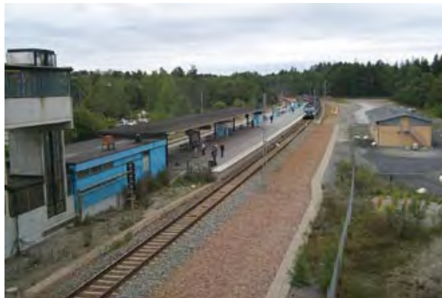
Kallhäll station mot söder.
