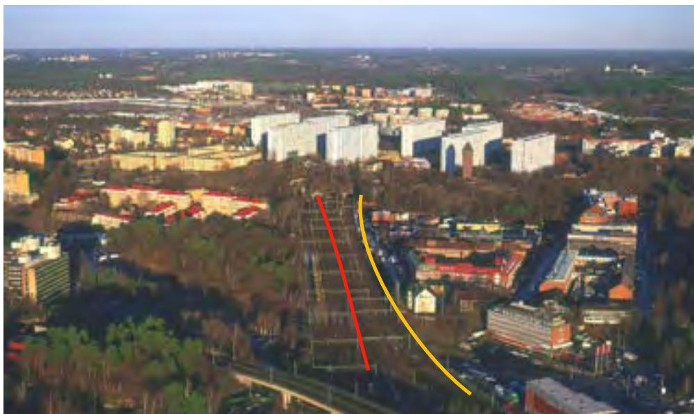
Flygbild mot norr. Ostkustbanan från Tomtebodavägen mot Solna med föreslaget nytt spår till höger/öster (orange) och befintligt spår som föreslås nyttjas för Mälmarbanan i mitten (röd). Denna sträcka är gemensam för de båda alternativen via Kista. De två spåren för befintliga Mälmarbanan viker av mot Huvudsta i bildens nederkant.
