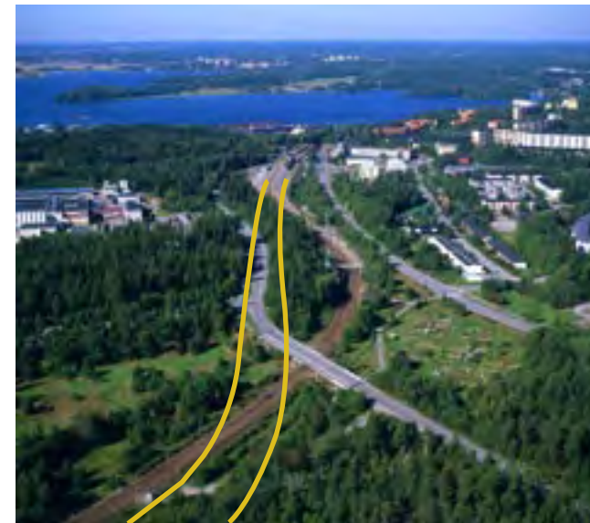
5. Kurvan söder om Kallhäll station. Kurvrätningen ger med denna dragning ett intrång i Görvälns naturreservat.
