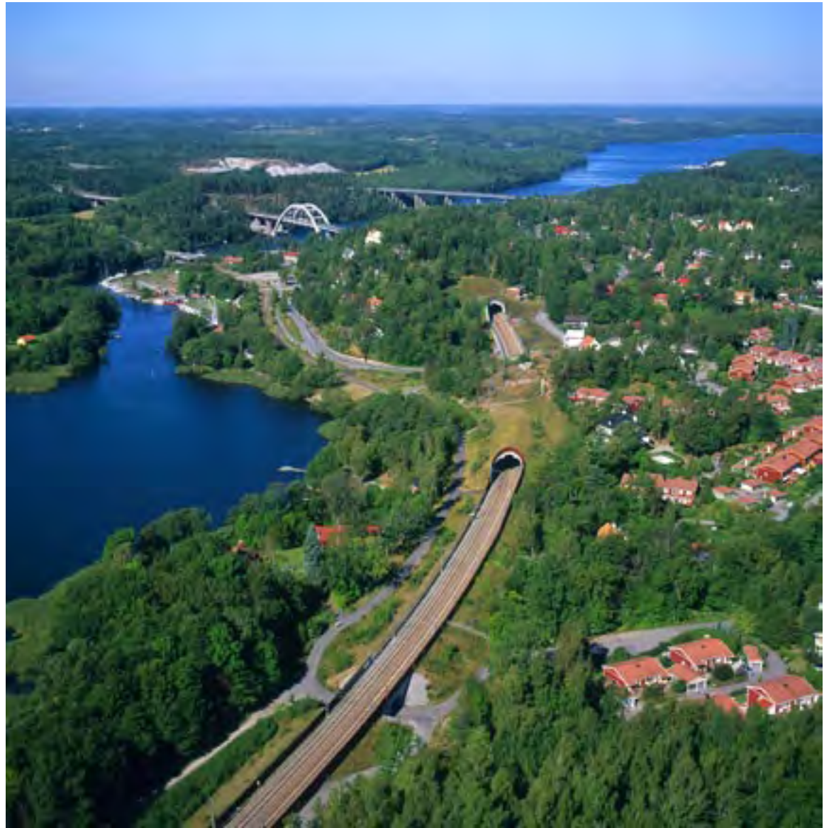
Tillgängligheten till strandlinjen förbättrades i norra Kallhäll efter dubbelspårutbyggnaden mellan Kallhäll och Kungsängen.
