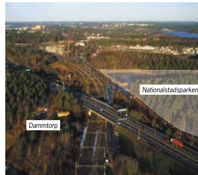
Ostkustbanan norrut. Korsningen med E4 i förgrunden och längre bort Silverdal och Sollentuna C. Dammtorps kulturvärde bör beaktas när spårlägen enligt Kista korridor studeras.
