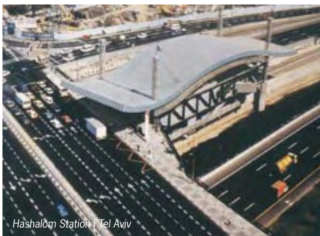
Exempel på utformning av tak över plattformarna.
