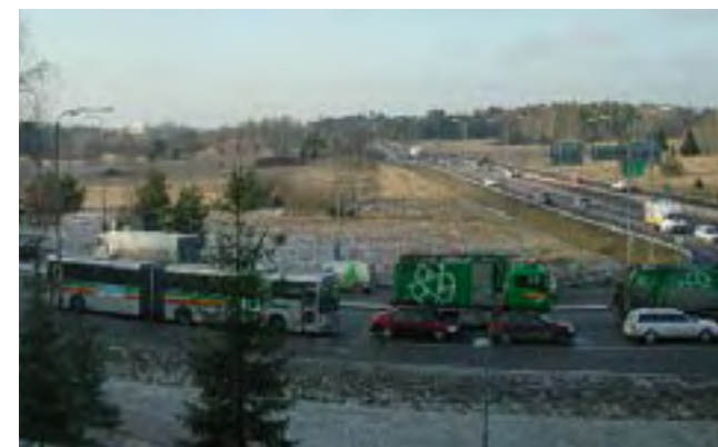
Vägverket planerar för ombyggnad av E18 Kista – Hjulsta. Bilden visar Hjulstakorset i dagsläget, med Bergslagsvägen i förgrunden.
