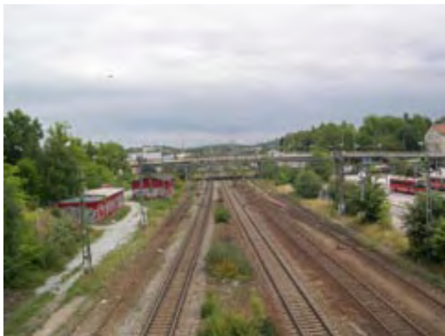
Spånga station mot söder. Förbi stationen är det idag fem spår.
