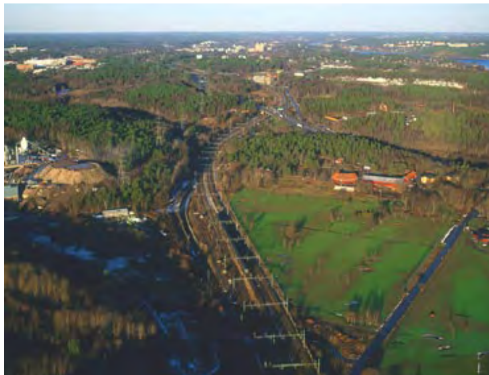
Flygbild, Ostkustbanan mot norr vid passagen av Överjärva gård.
