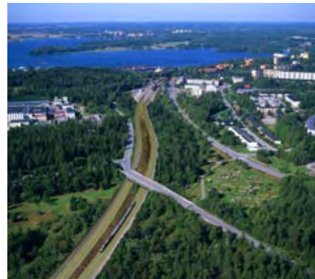
En breddning ger långsgående ingrepp i landskapet.
