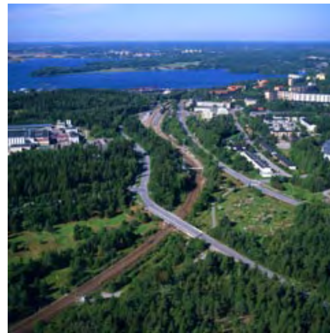
Mälardalsbanans passage av Görvälns naturreservat på den vänstra (västra) sidan av spåret. På den västra sidan ligger också en hagmark och en ekbacke klassad som nyckelbiotop.
