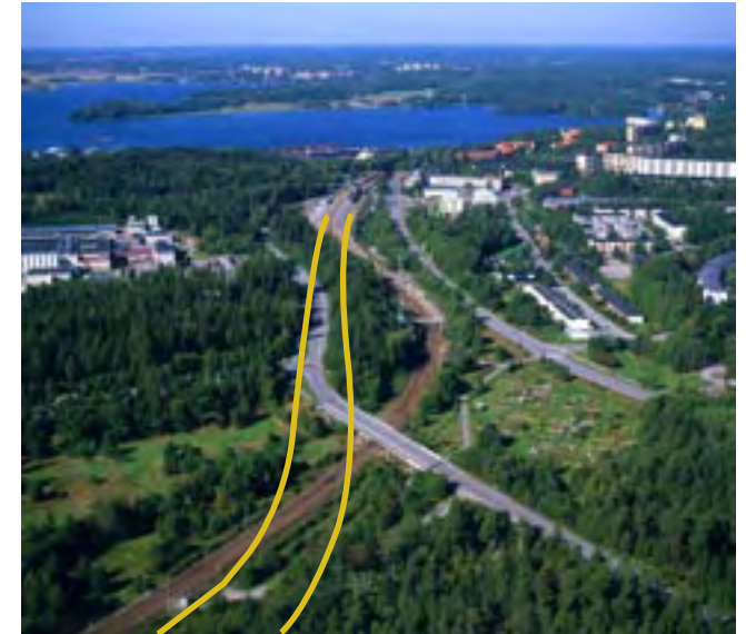
5. Kurvan söder om Kallhäll station. Kurvrätningen ger med denna dragning ett intrång i Görvälns naturreservat.
